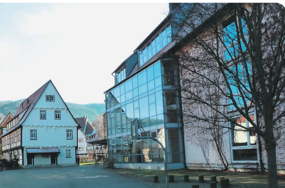
Hier entsteht eine Gemeinschaftsschule: Grund- und Werkrealschule Bad Urach
