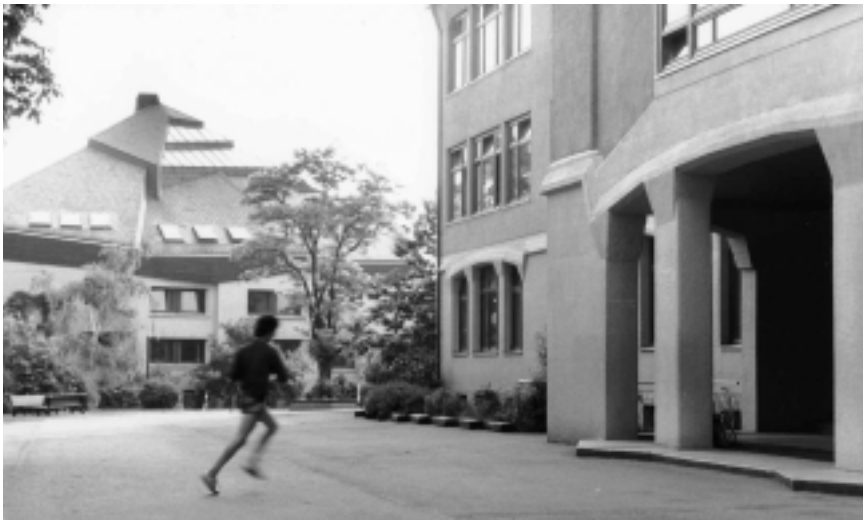
Das Foto zeigt den Eingangsbereich der ersten Waldorfschule („Mutterschule“) in Stuttgart an der Uhlandshöhe, die auch so heißt: Waldorfschule Uhlandshöhe
